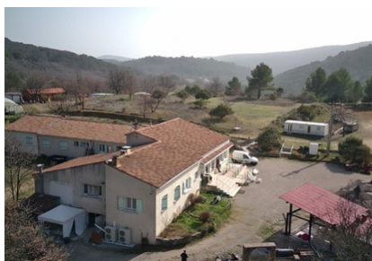
Construction chalets d'hébergement
